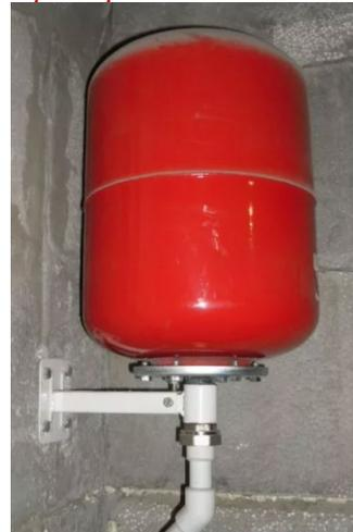
4.4. При монтаже резьбовых соединений не допускается превышать крутящий момент 25 Нм.
